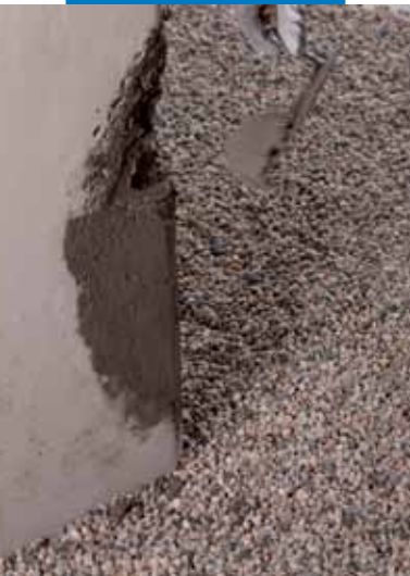
Applicazione a cazzuola di Mapegrout LM2K
