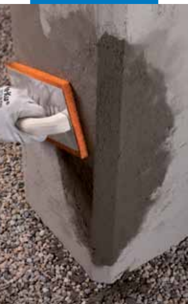
Frattazzatura di Mapegrout LM2K
