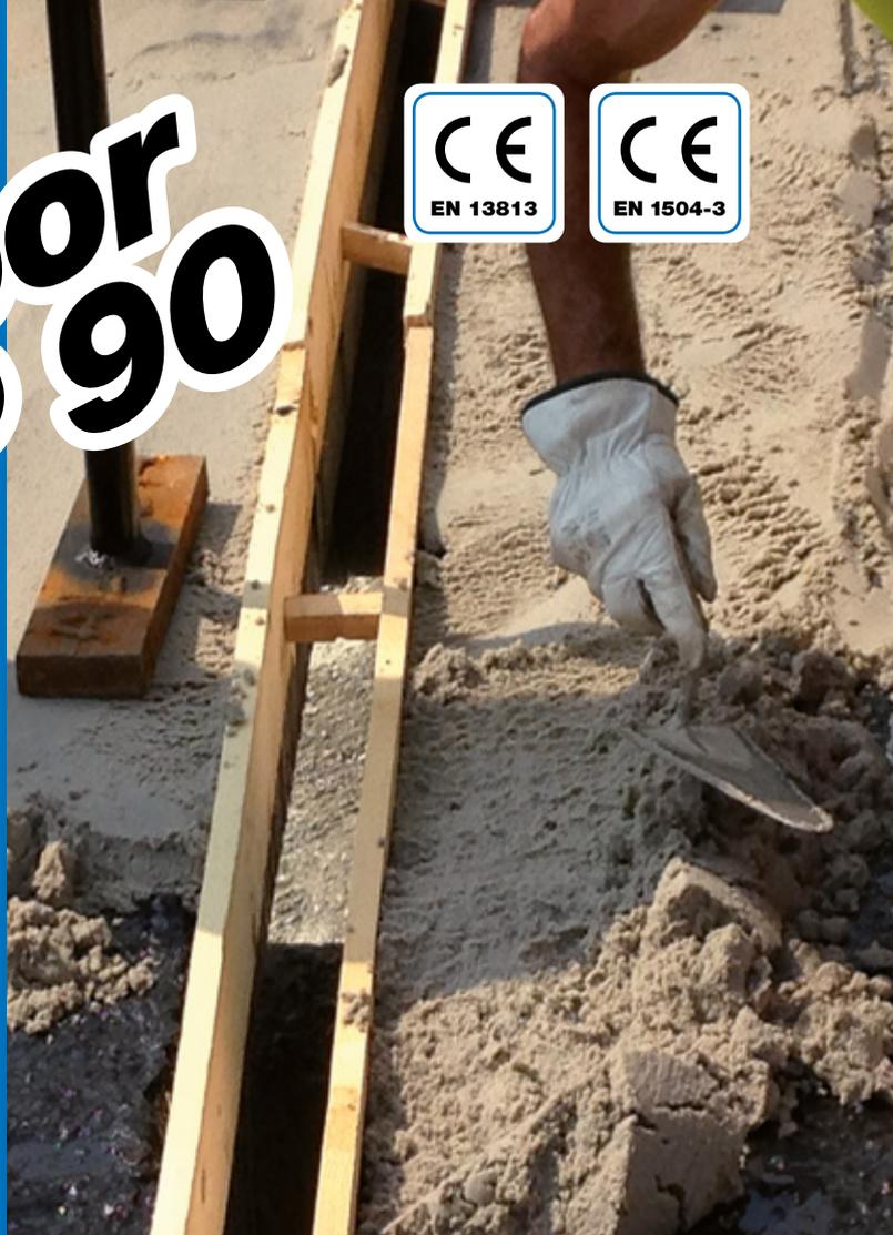
**Malta epossidica tricomponente ad elevate prestazioni meccaniche, di consistenza terra umida per il ripristino di pavimentazioni in calcestruzzo e per la realizzazione dei piani di appoggio per travi e giunti**
