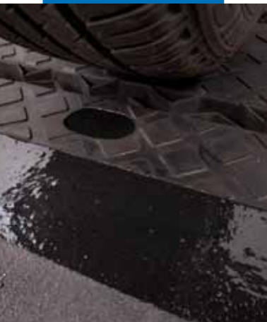
Mapeflex PU65 polimerizzato, pronto per il transito
