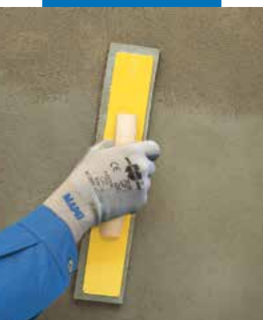
Lisciatura con frattazzino di spugna
