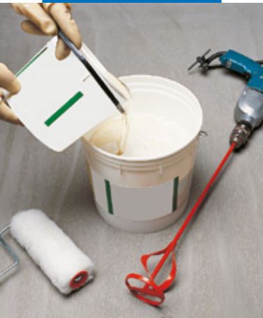
Miscelazione del componente B con il componente A
