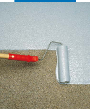
Applicazione di Mapecoat I 24 a rullo
