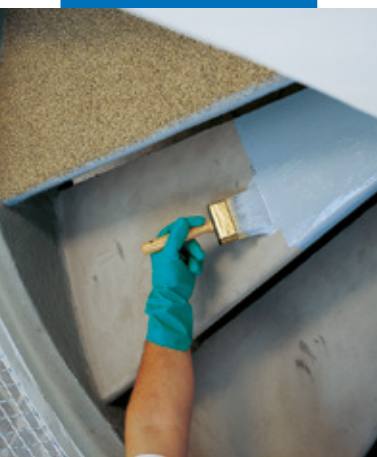
Applicazione di Mapecoat I 24 su calcestruzzo
