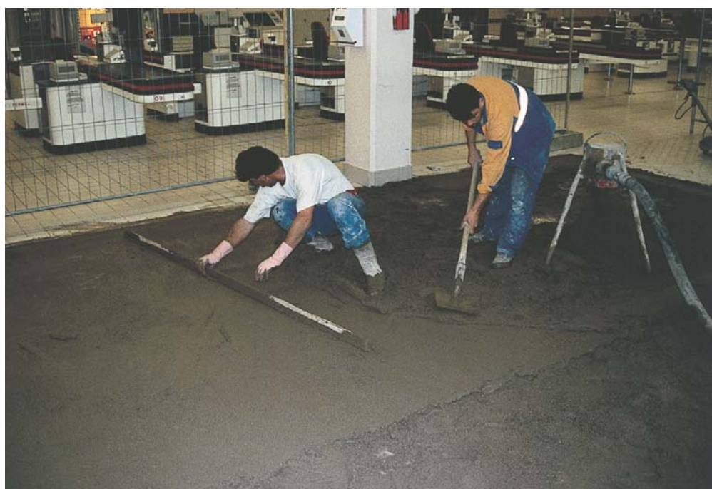
Rifacimento rapido di massetto in un supermercato
