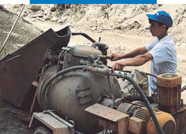
Impasto di Mapecem con impianto automatico di pompaggio
