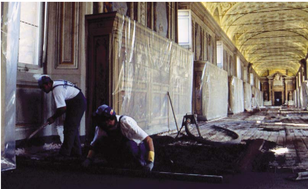
Stesura e finitura del massetto in Mapecem - Saloni Sistini - Città del Vaticano
