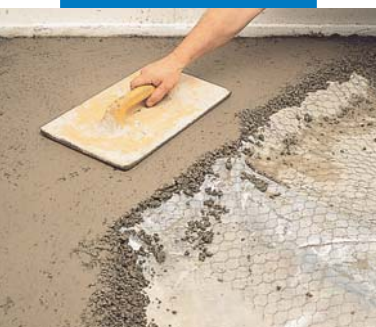
Copertura di tubazioni con Mapecem e rete di rinforzo
