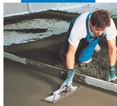
Finitura con frattazzo di impasto in Mapecem
