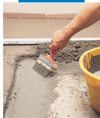
Stesura di boiaccia di ancoraggio per massetti in Mapecem aderenti
