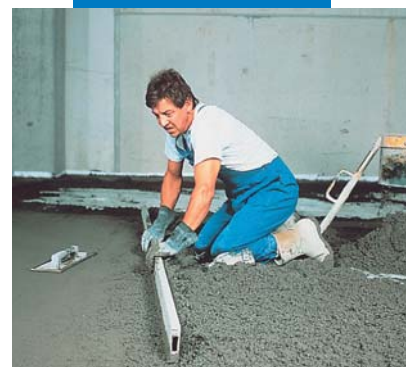
Staggiatura di impasto in Mapecem
