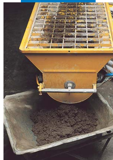
Impasto di Mapecem con minibetoniera
