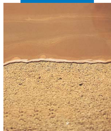
Finitura di massetto in Mapecem con Ultraplan autolivellante
