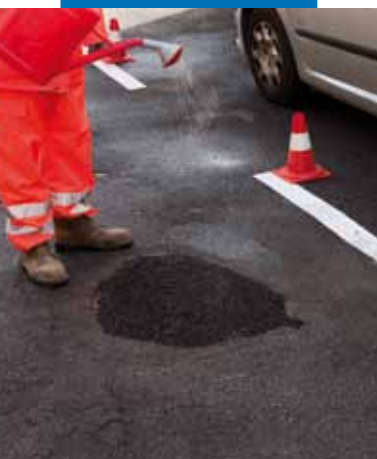
Bagnatura della superficie di Mape-Asphalt Repair 0/8
