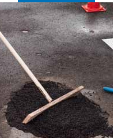
Applicazione e stesura di Mape-Asphalt Repair 0/8
