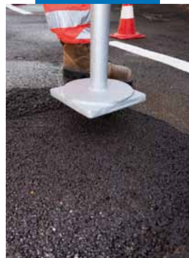
Compattazione manuale di Mape-Asphalt Repair 0/8
