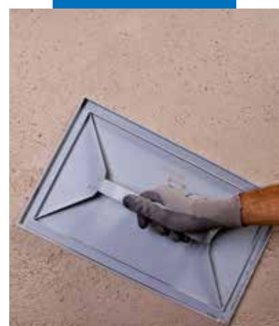
Ripianatura di Mape-Antique Strutturale NHL
