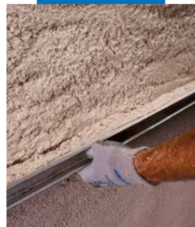
Staggiatura di Mape-Antique Strutturale NHL
