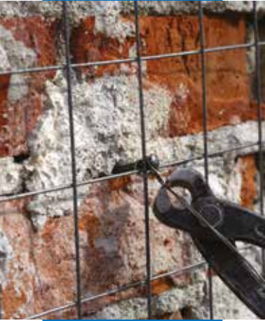
Fissaggio di rete zincata alla muratura
