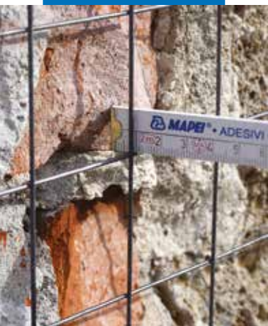
Verifica della distanza fra la rete e il supporto
