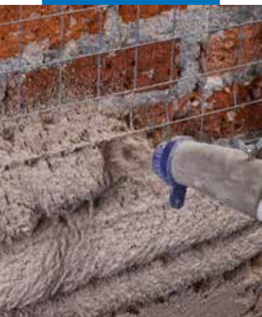
Applicazione a spruzzo di Mape-Antique Strutturale NHL
