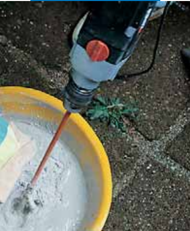
Preparazione di Mape-Antique I
