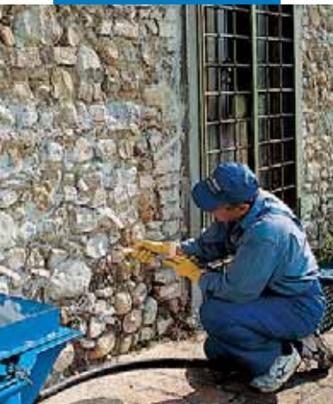
Iniezione di consolidamento con Mape-Antique I
