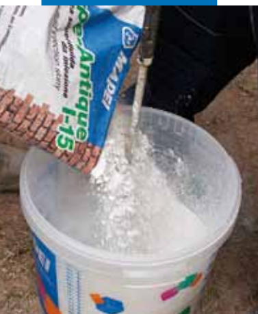
Preparazione di Mape-Antique I-15
