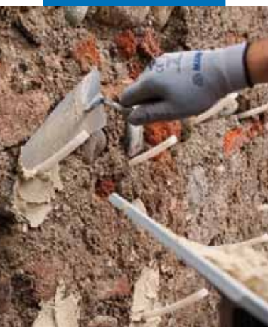
Fissaggio dei tubicini di gomma con Mape-Antique Allettamento
