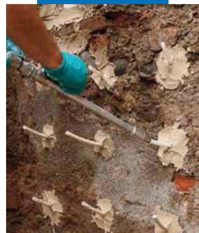
Iniezione di Mape-Antique I-15
