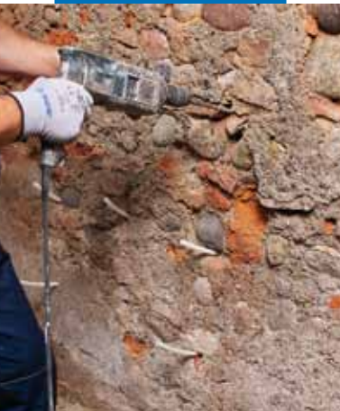
Realizzazione di fori
