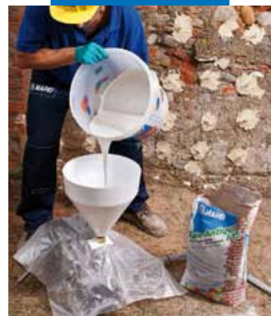
Riempimento della tramoggia con Mape-Antique I-15
